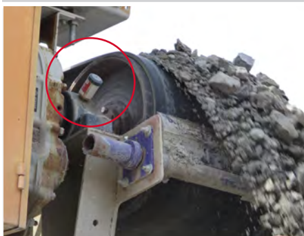
Lubricación del cojinete de soporte de una cinta transportadora
