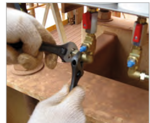
Coloque codos y adaptadores en el soporte
