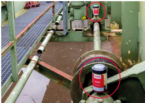
Lubricación de rodamientos en el separador
