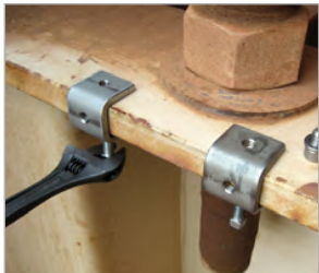
Monte las pinzas de montaje en el bastidor
